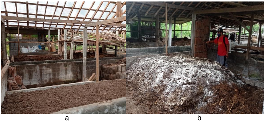
Gambar 6. Bangunan penampungan feses ternak (a) dan bangunan pengolahan feses (b) yang ada di Kelompok Ternak Ngudi Rejeki
